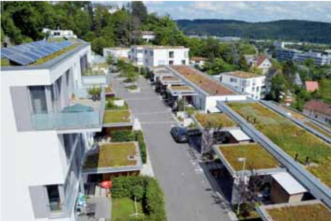
Grüne Dächer nutzen nicht nur der Umwelt, sondern verlängern auch das Leben der Dachkonstruktion.
