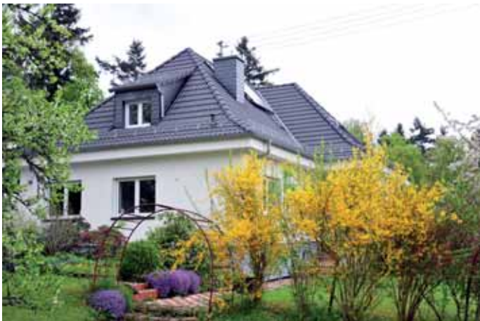
Neu und modern: Das 60 Jahre alte Haus von Familie Georgiadis erstrahlt in neuem Glanz - und spart dabei auch noch enorm Energiekosten ein. Foto: djd/IWO - Institut für Wärme und Oeltechnik
